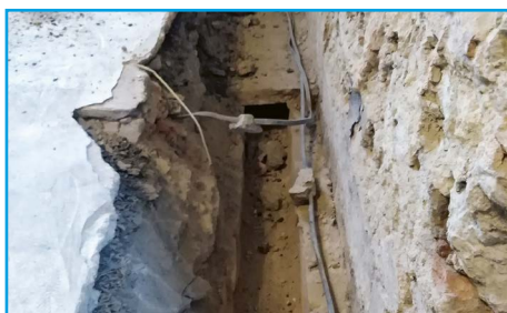
■ Pohled na část vnitřního odvětrání podlah
