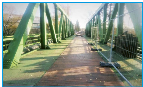
■ Práce na výměně dřevěné části mostu budou ukončeny v polovině prosince
