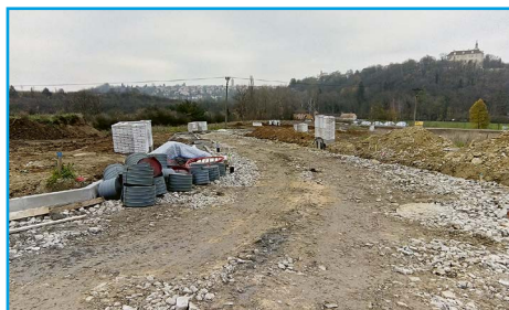
■ Výstavba technické infrastruktury pro 23 RD v lokalitě Obodří - dokončené sdružené pilíře
