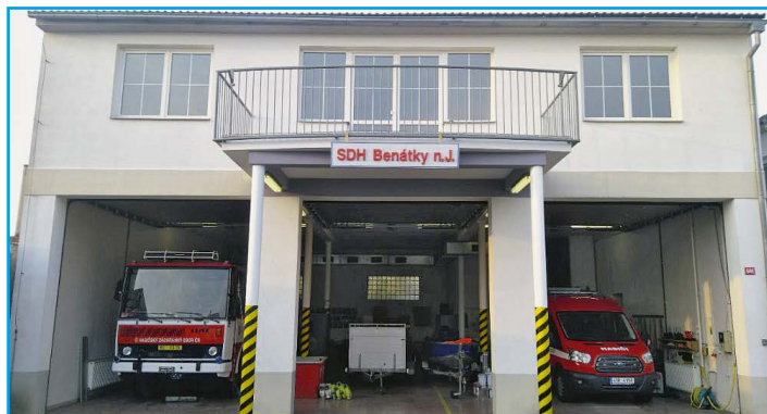
■ Sídlo Sboru Dobrovolných hasičů v Jiráskově ulici
