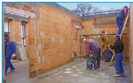
■ Dostavba polikliniky - v listopadu byla zahájena stavba vlastní budovy
