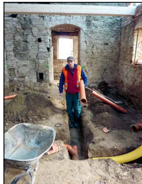
■ Rekonstrukce na Plajchu z důvodu nutnosti splnění podmínek dotace pokračuje velmi rychle
