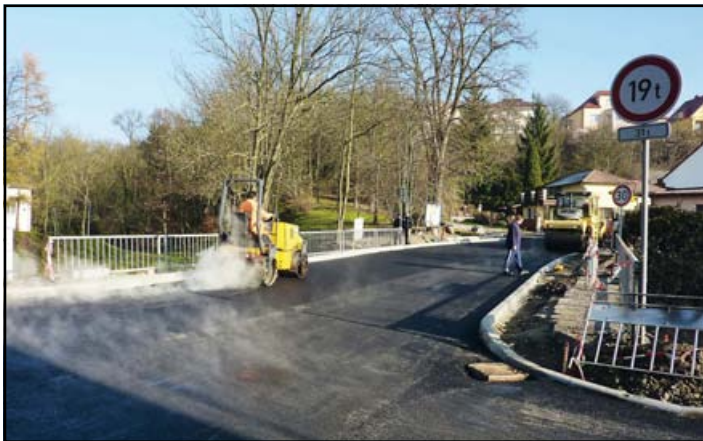
■ Rekonstrukce komunikace v ulici Soumarova – pokračují práce na rekonstrukci mostku
