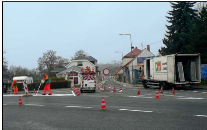
■ Rekonstrukce komunikace v ulici M. Soumara je v této části téměř dokončena
