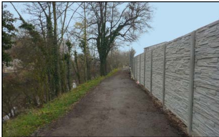
■ V úvodu realizace cyklostezky bylo provedeno zejména veřejné osvětlení části mezi ulicí M. Soumara a ulicí U Cukrovaru
