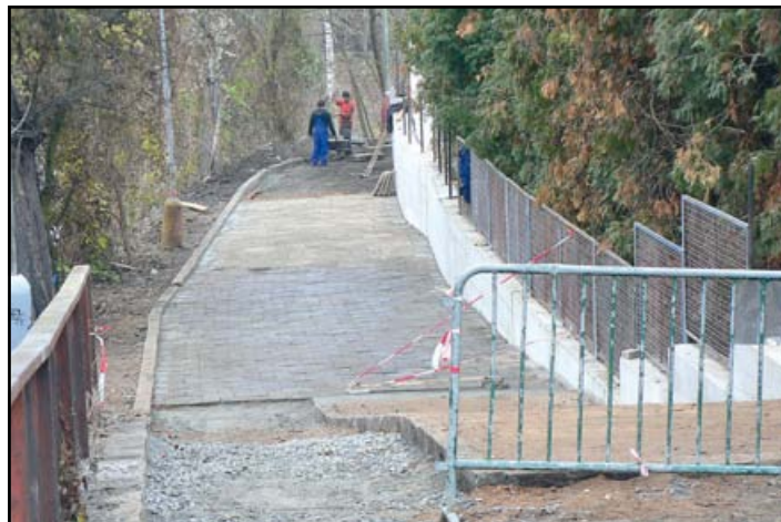
■ Protipovodňová ochrana města
