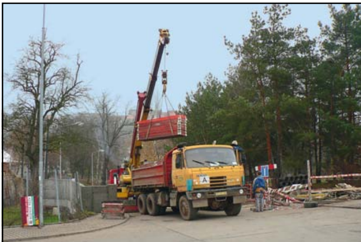
■ Pokračuje výstavba protipovodňové železobetonové zdi v části za mateřskou školkou Jizerka a poliklinikou
