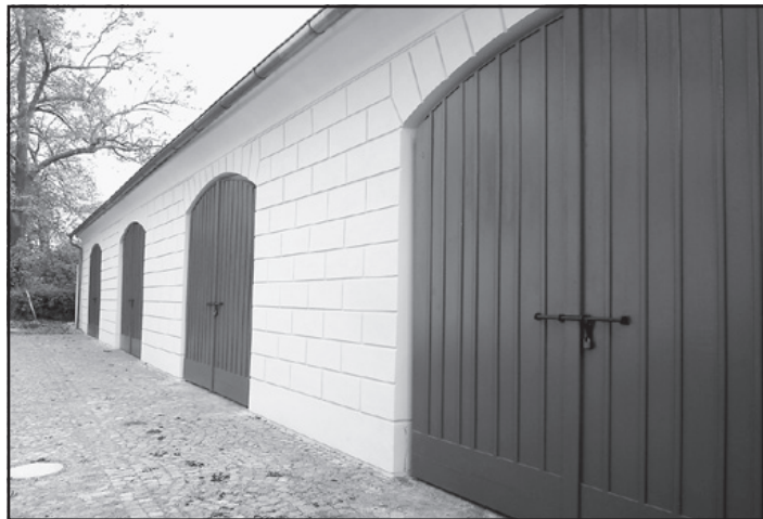
Rekonstrukci kočárovny v zámeckém areálu dokončila firma Dalibor Frňka, Frýdek - Místek v termínu
