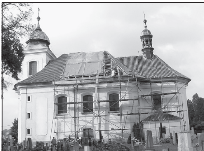
Na snímku jsou zachyceny probíhající práce na pokládce nové střešní krytiny v druhé polovině měsíce října
