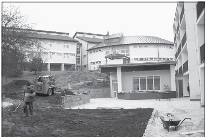
Probíhající úpravy venkovních prostor - snímek ze dne 24. 11. 2011
