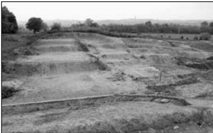
Dokončení hrubých prací na bmx trati, na jaře nás čeká položení finálního povrchu, první tréninky a závody
