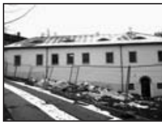
Oprava čp. 50 v zámeckém areálu – pohled z „plajchu“
