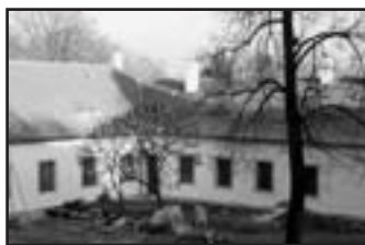
Oprava čp. 50 v zámeckém areálu – pohled od zámku
