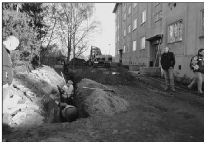
Ve druhém týdnu měsíce byly na náměstí 17. listopadu zahájeny práce na odstranění starých podkladních vrstev a práce na nové stoce kanalizace
