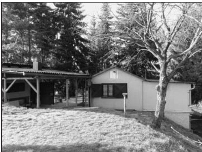
Rybářská chata v Kochánkách po rekonstrukci
