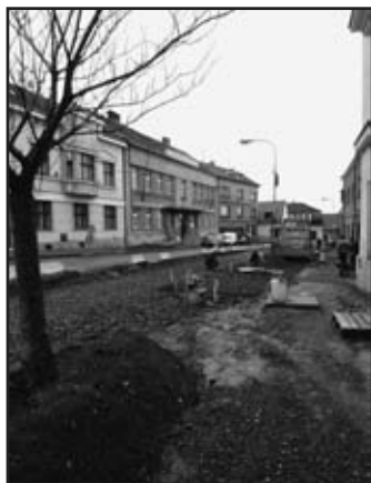
Ve Vaněčkově ulici probíhá pokládka dlažby
