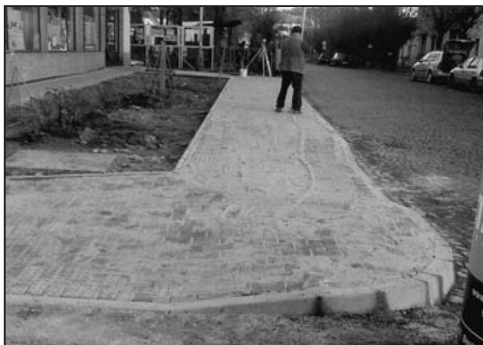
V ulici Dražická se před prodejnou JIST dokončuje rekonstrukce chodníku Fota na straně 2 a 3: MěÚ
