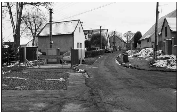
Výstavba kanalizace v ulici Dělnická je v závěrečné fázi
