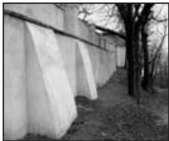
Také oprava zámecké zdi byla dokončena. Zbývající drobné nedodělky budou zahrnuty do opravy zámeckého parku
