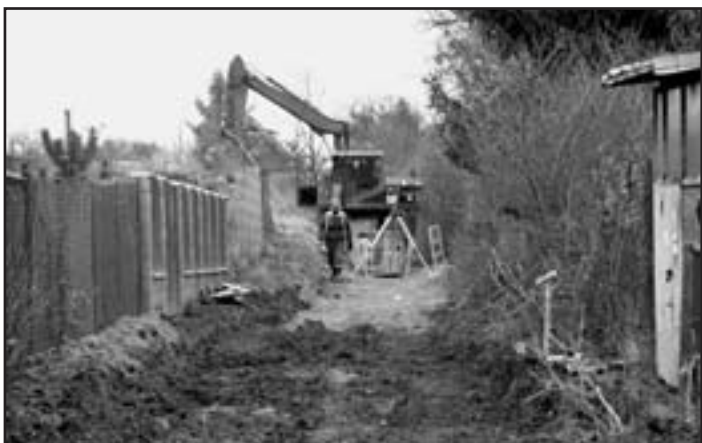
Výstavba kanalizace v ulici Raabova
