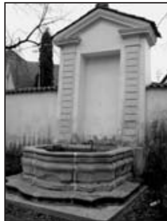
Oprava kašny v zámeckém parku byla dokončena. Na jaře bude ještě doopraveno barevné tónování spár i doplnění drobných kamenných bloků.
