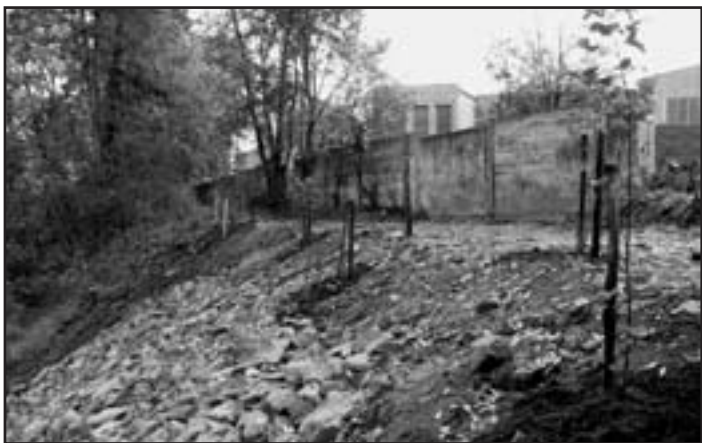
Opravený úsek byl doplněn o novou výsadbu
