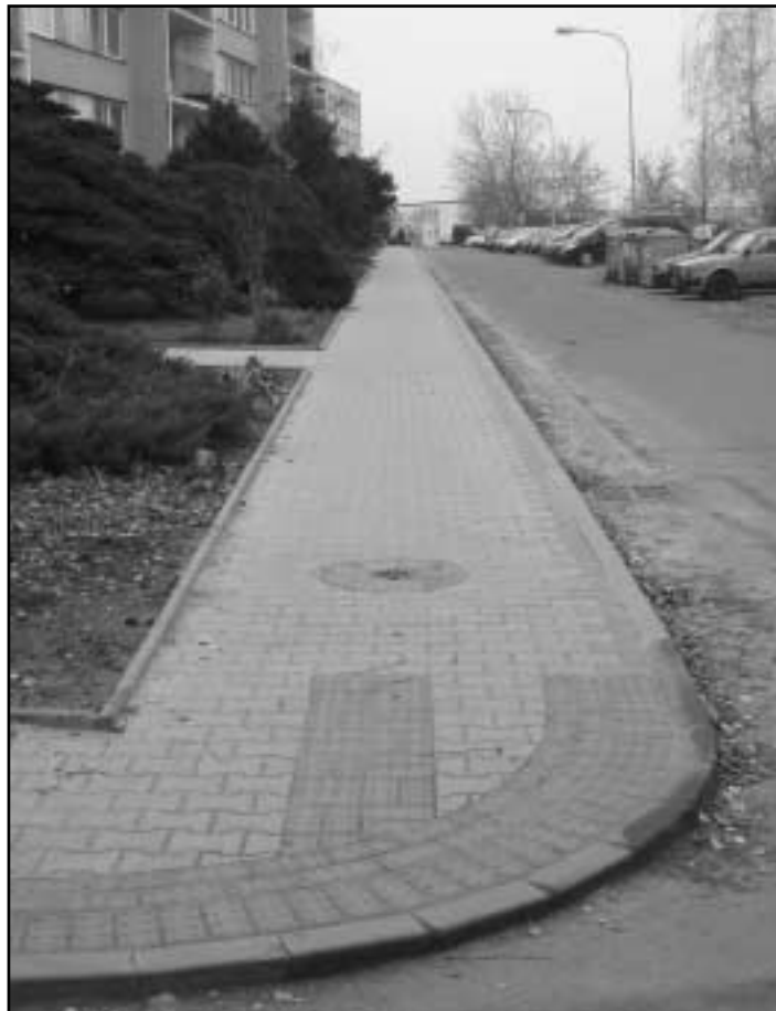
Nový chodník v ulici Ořechová
