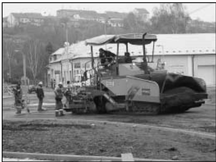
Výstavba okružní křižovatky - v sobotu 2. a v neděli 3. prosince 2006 se pokládaly finální asfaltové vrstvy. Prostor Na Burse, kde tyto práce probíhaly, byl v uvedených dnech pro dopravu uzavřen.
