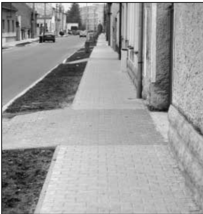
Chodník v ulici Lidická po rekonstrukci
