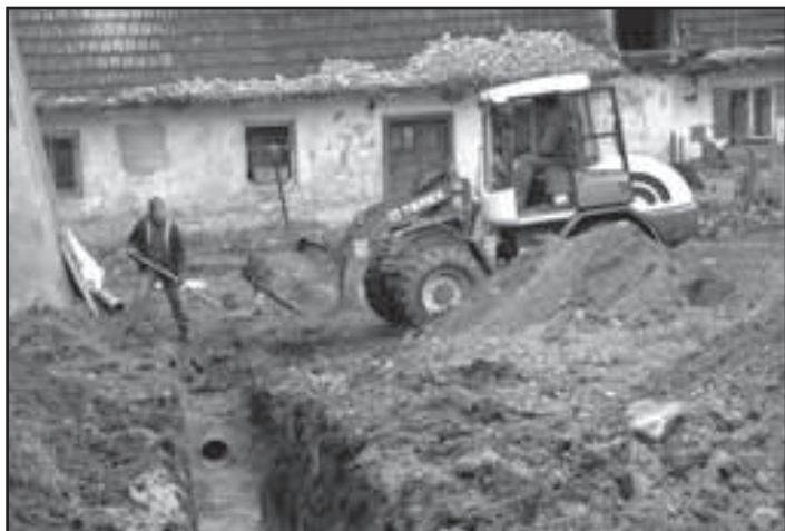
Výstavba dešťové kanalizace v areálu zámku (zámecký park) - výkopové práce 10. listopadu
