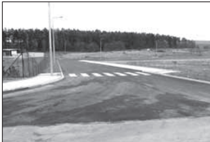
Dostavba místní komunikace v průmyslové zóně.
