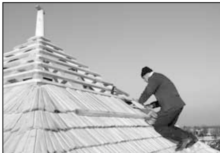
Pilně se pracuje na zastřešení staré vodárny ve Vaněčkově ulici.
