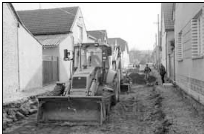
Rekonstrukce Lipnické ulice
