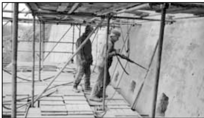
Práce v Podolecké ulici pokračují úpravou tarasu.
