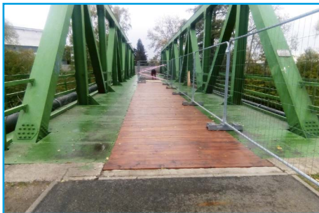
■ Oprava bývalého železničního mostu
