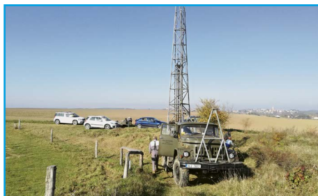
■ Vrtná souprava pro provedení geologického průzkumu
