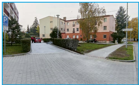
■ Dokončené zpevněné plochy u MěCKP na náměstí 17. listopadu
