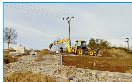
■ V lokalitě Nad stadionem probíhá vyzdívání sdružených pilířů
