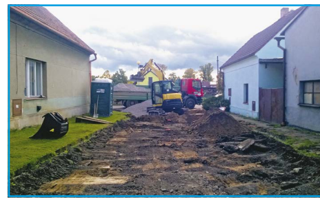
■ V městské části Kbel probíhá oprava povrchu komunikací
