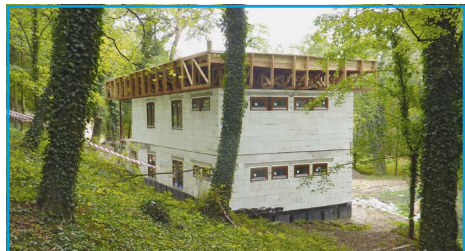
■ Na budově jsou osazena okna a dveře
