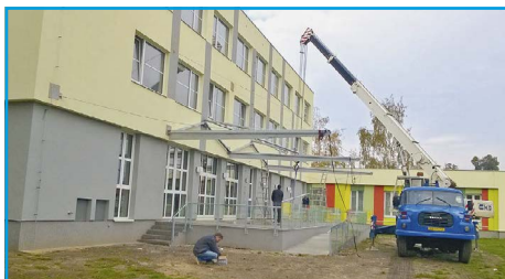
Nad terasou multifunkčního centra byla v říjnu dokončena montáž nového zastřešení
