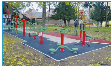
■ Koncem měsíce října byla dokončena výstavba nového hřiště pro seniory v parku Ferdinanda Barty
