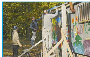
■ Zvládli jsme i stavbu přístřešku
