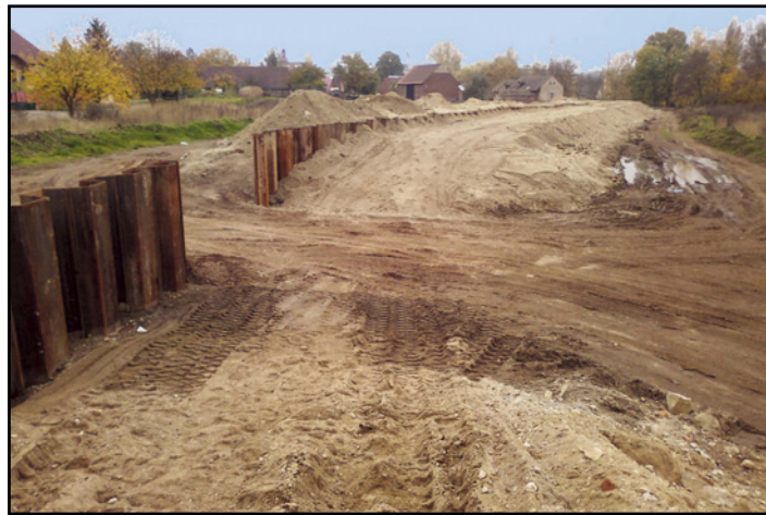
■ Protipovodňová ochrana města Benátky nad Jizerou – výstavba sypané hráze, která vznikne souběžně s ulicí V Olšinách
