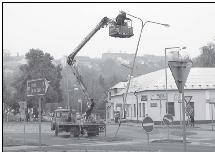
Technické služby města odstraňují stožár veřejného osvětlení
