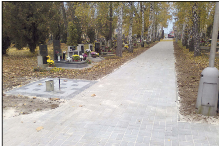
■ Poslední říjnový týden byla dokončena úprava hlavní cesty včetně ploch kolem kaple na hřbitově v Nových Benátkách
