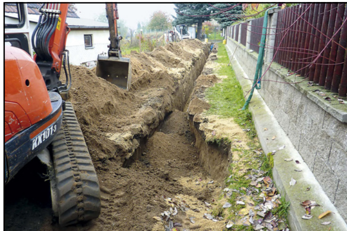
■ V ulici Pod Brdy se buduje nový vodovod
