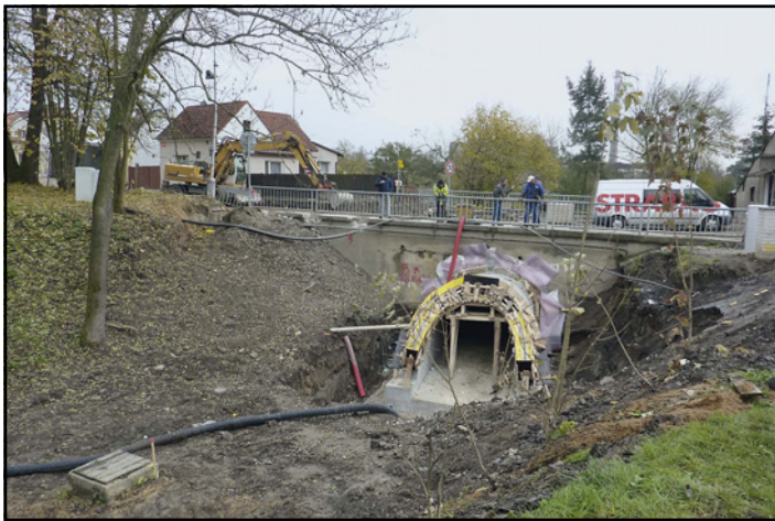
■ Rekonstrukce komunikace v ulici Miroslava Soumara – pokračují práce na rekonstrukci a zpevnění mostku u městské části Obodř
