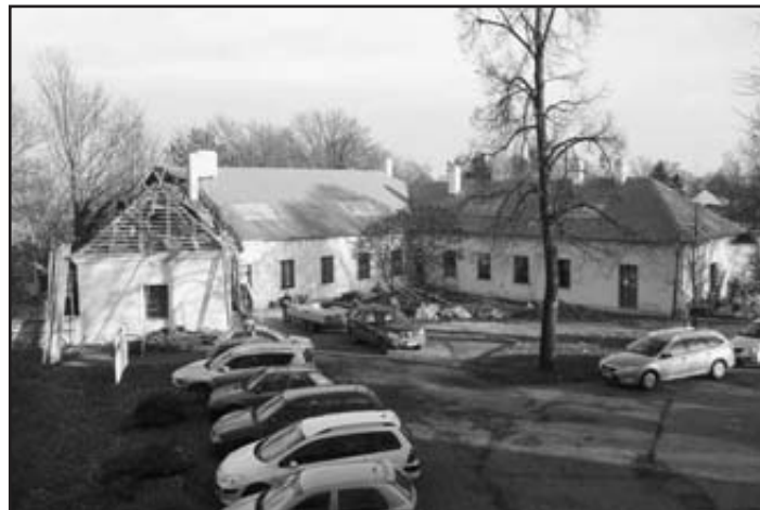
Střední a východní křídlo v čp. 50 v zámeckém areálu jsou hotovy, začaly práce na posledním - západním křídle budovy
