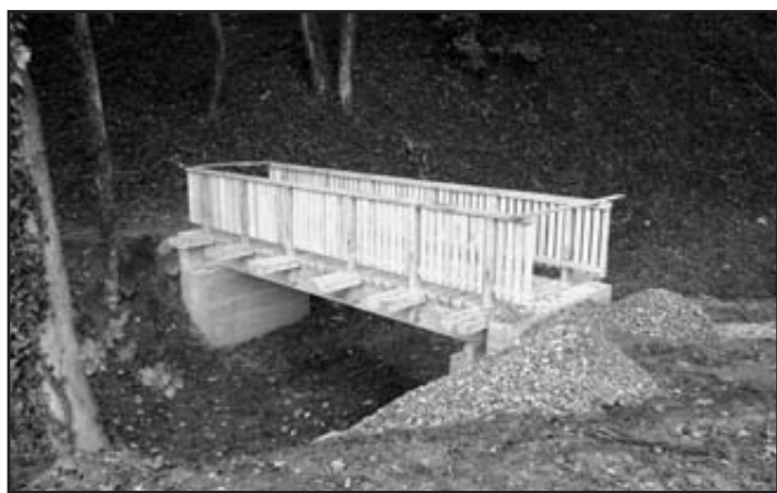
Stavba tří můstků přes strž v zámeckém parku je dokončena Foto: MěÚ
