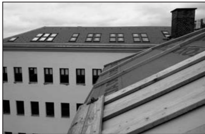
ZŠ Husovo náměstí – půdní vestavba: v říjnu pokračovalo osazování střešních oken
