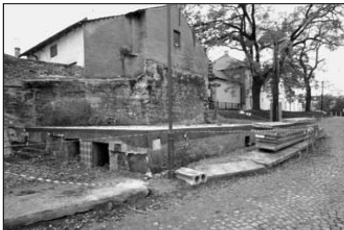
Azylový dům pro ženy a matky s dětmi – po dokončení demolice se vybudovaly nové základy a vybetonovala základová deska Foto: MěÚ
