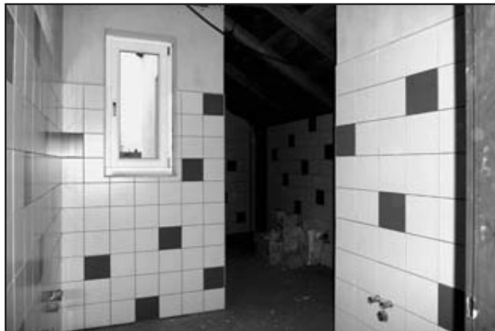
ZŠ Husovo náměstí – půdní vestavba: V novém sociálním zařízení byly provedeny obklady
