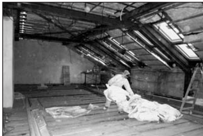
ZŠ Husovo náměstí – půdní vestavba: Osazování kovových roštů
