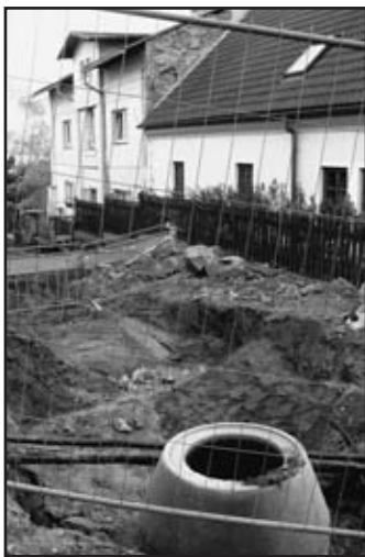
Na Vyhliďce Jaroslava Matouška se pokládá kanalizační řad, do kterého se zaústí dešťové svody i splaškové přípojky z okolních domů Fota na straně 2 a 3; MěÚ
