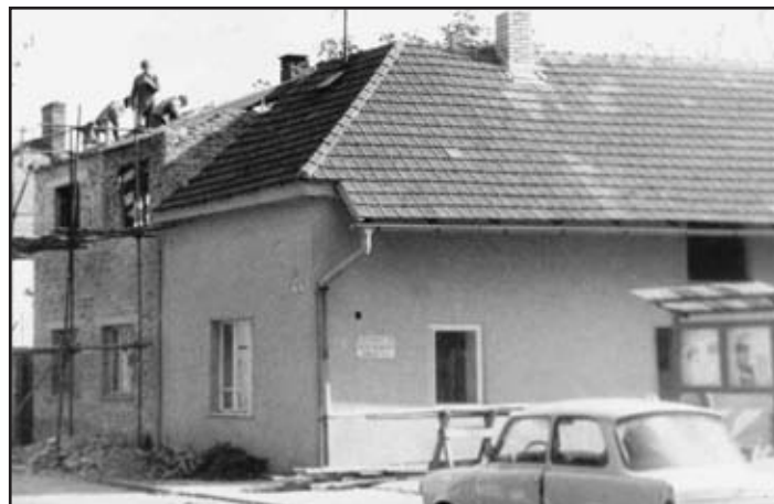
Z přilehlého domku, získaného od Města Benátky nad Jizerou, rybáři budovali v přízemí pionýrskou klubovnu, skladovací prostory a kancelář v prvním poschodí. Fotografie poskytla MO ČRS Benátky nad Jizerou
