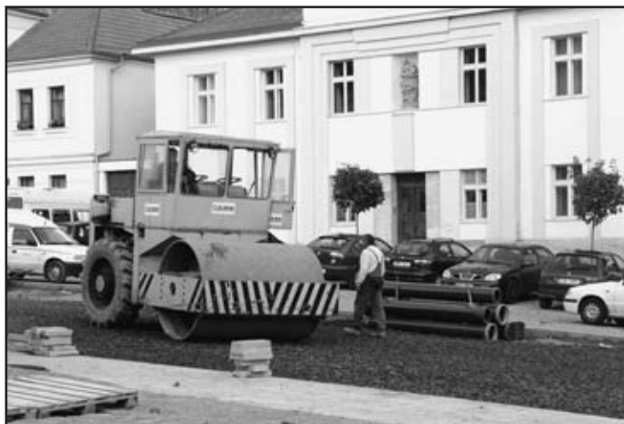
Na Husově náměstí se dokončují povrchy komunikací
