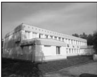
Celkové náklady na zateplení polikliniky v Benátkách nad Jizerou II dosáhly výše 2 990 149 Kč
