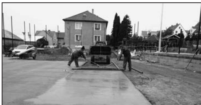
V měsíci říjnu byl při výstavbě víceúčelového hřiště v lokalitě U Silvie vybetonován podklad pro položení umělého trávniku
