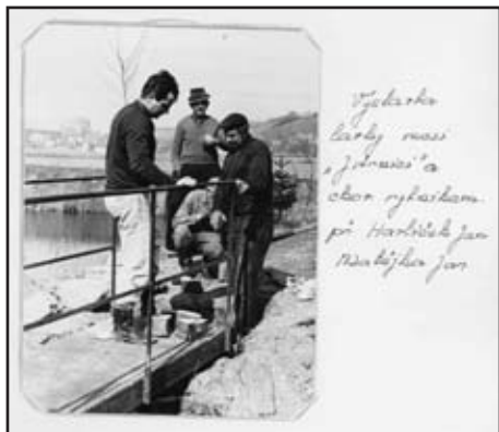
Výstavba lávky mezi „jitrnicí“ a chovným rybníkem
