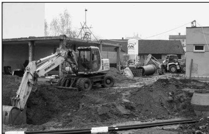
Přeložky vodovodu, teplovodu a kanalizace jsou téměř dokončeny
