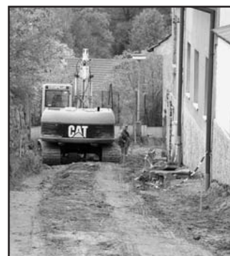
V ulici Smetanova se dokončují poslední práce na rekonstrukci vozovky plánované na letošní rok
