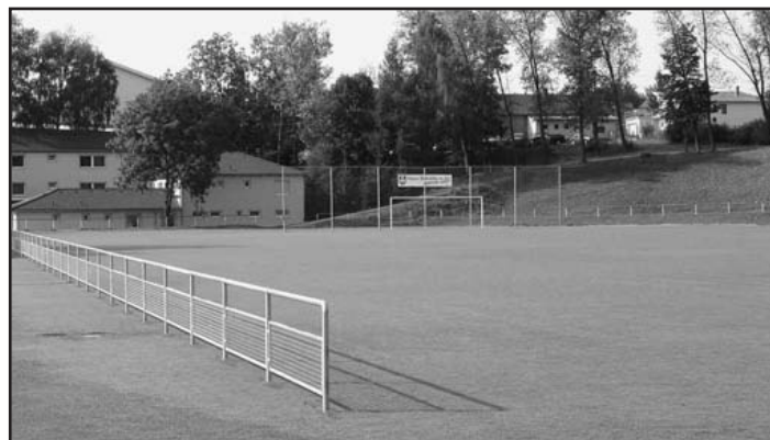
Na fotbalovém hřišti bylo v letošním roce vybudováno po jedné straně hrací plochy ohrazení o výšce 1,2 m s výplní o délce 110 metrů a za oběma brankami vzniklo obdobné ohrazení o výšce 5 m a délce 30 m, které je vyplněno pletenou sítí.
