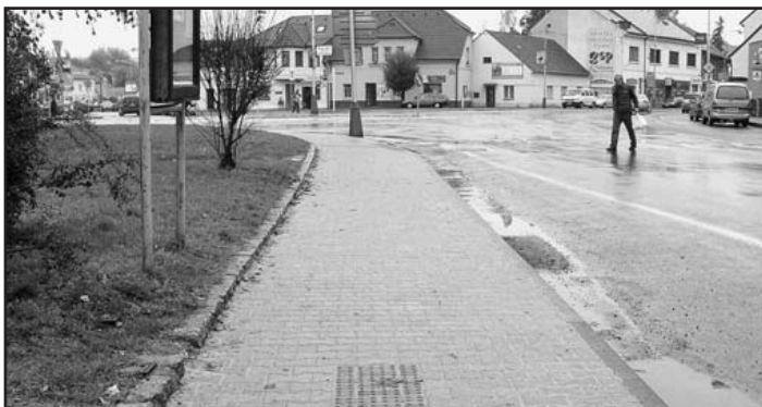
Tato část chodníku prošla úplnou rekonstrukcí
