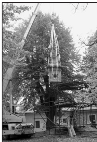
Socha byla pomocí jeřábu snesena
