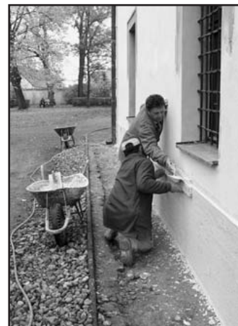
Po vyvrácení nové omítky bude proveden první nátěr
