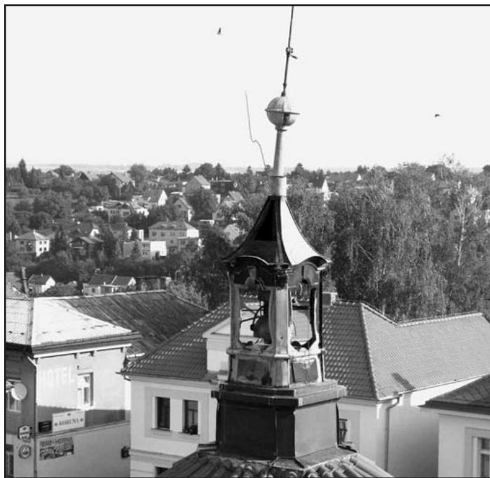
Delší dobu jsme si mohli povšimnout nakloněné špičky věžičky kaple sv. Rodiny na Husově náměstí, kterou firma Dalibor Fríka, Frýdek-Místek v současné době opravuje
