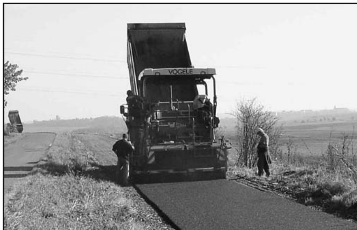
Pokládání asfaltového betonu na trase Chrástecký Dvůr - Zdětín koncem října
