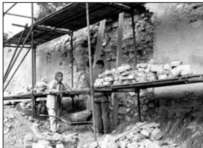
Posledním opravovaným úsekem zámecké ohradní zdi je část nad vinicí
