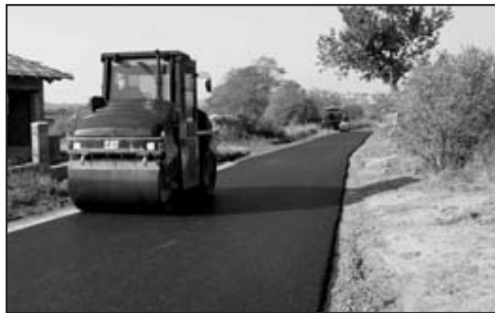
Na přístupové komunikaci ke sportovní rekreačnímu areálu ve Kbelu je položen asfaltový koberec
