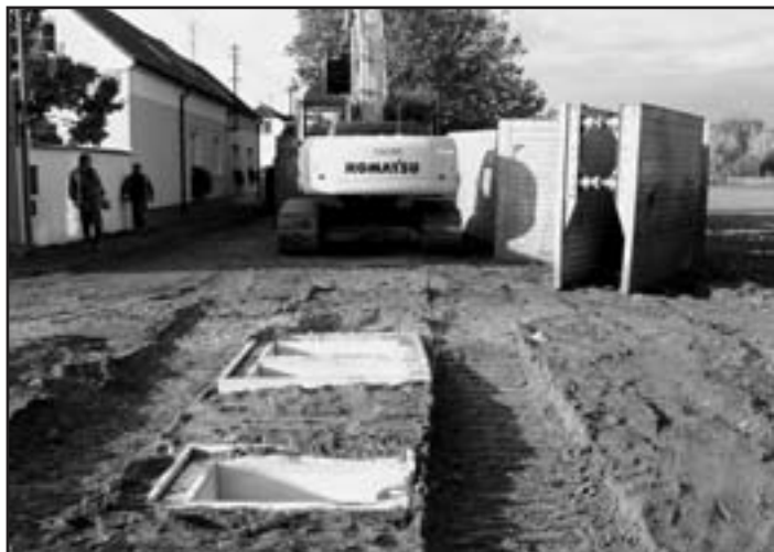
Výstavba kanalizace v ulici V Olšinách probíhá dle harmonogramu
