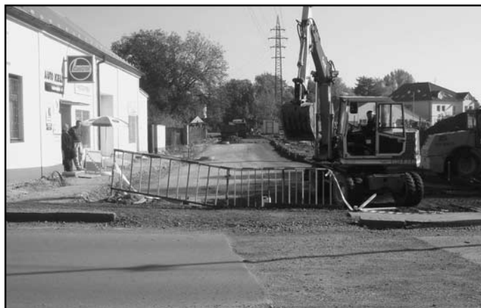
Výstavba komunikace ke Karbu
