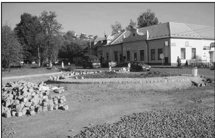
Výstavba kruhového objezdu pokračuje
