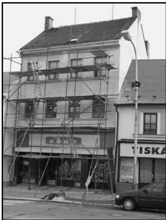
Husovo náměstí, čp. 12 „Baťovna“ – probíhá oprava fasády
