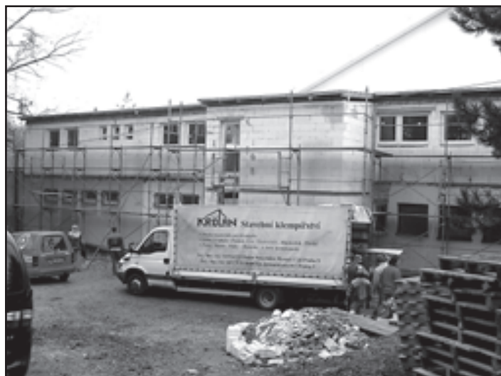
Nástavba sociálního zázemí na zimním stadionu
