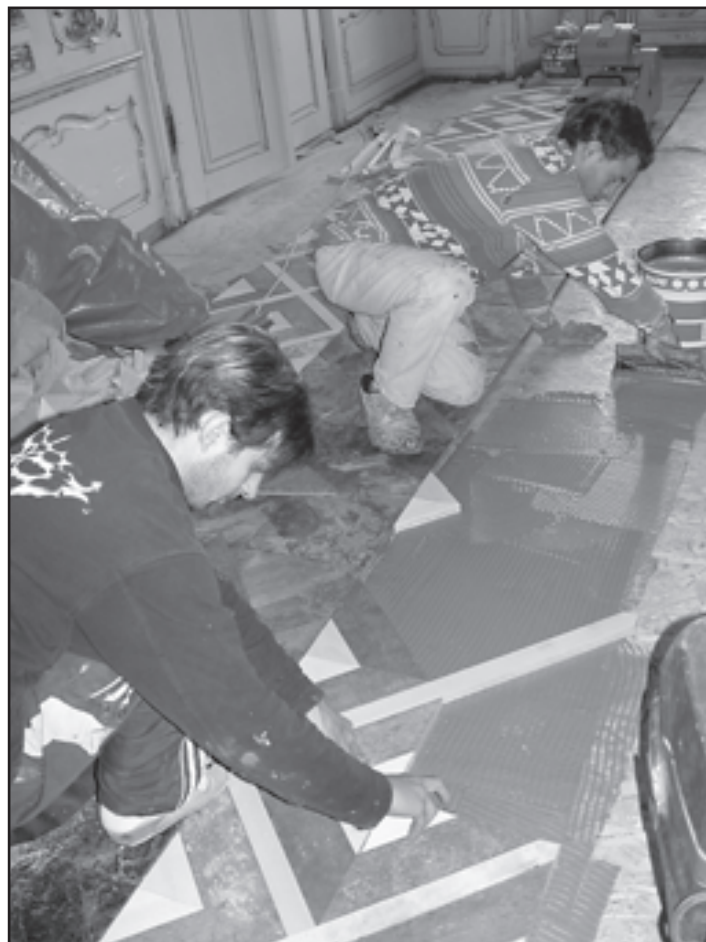
V prostorách městského úřadu probíhá rekonstrukce parketové podlahy v „Růžovém salonku“. Část původních parket zůstává zachována.
