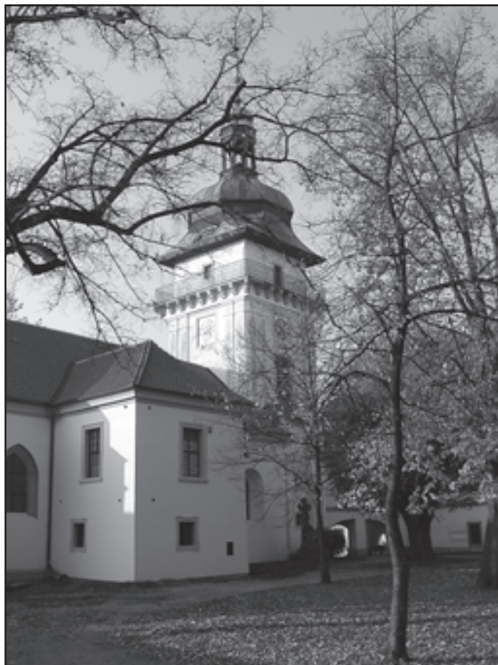
V nejbližších dnech bude zahájena výstavba dešťové kanalizace v okolí zámeckého kostela.
