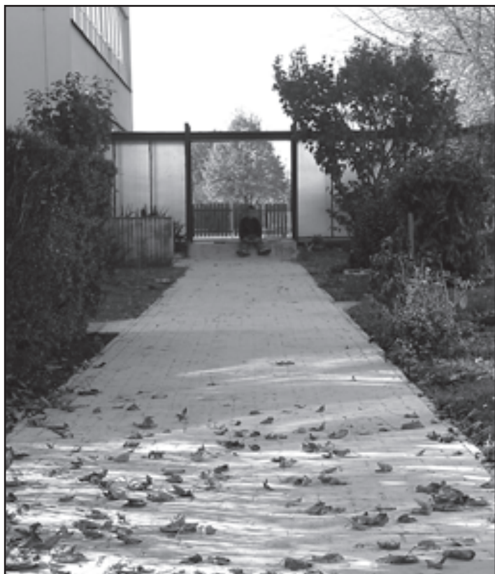
Rekonstruovaný chodník v Mateřské škole Poupátka v Platanové ulici.
