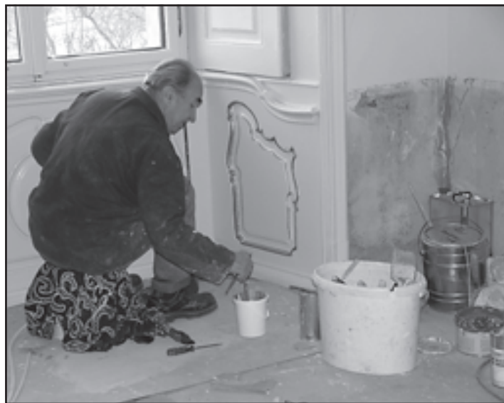
Ve velké zasedací místnosti městského úřadu se provádějí nátěry oken, obložení, okenic a dveří. Nátěry linek vyžadují skutečně pevnou ruku.
