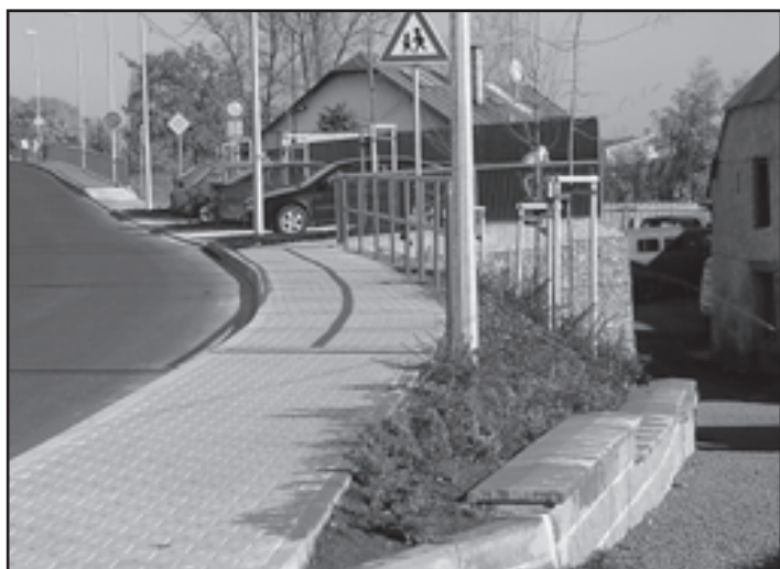
Podolecká ulice s novým povrchem vozovky a novým chodníkem
