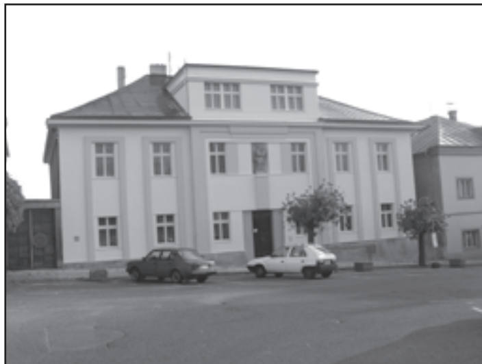
Oprava fasády, oken a vstupních dveří čp. 76 na Husově náměstí je ukončena včetně restaurace vzácné sochy Panny Marie.
