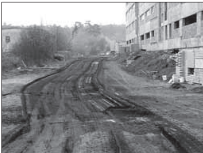
Výstavba komunikace v průmyslové zóně
