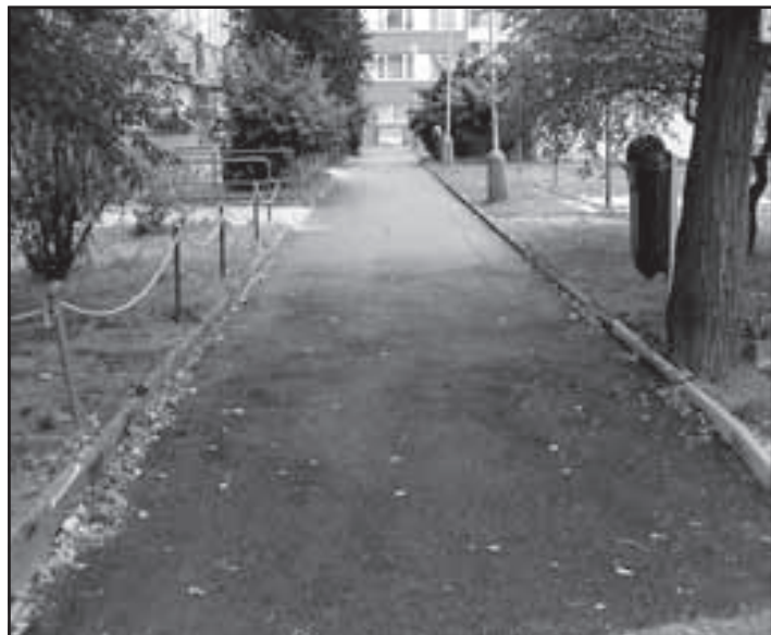
Oprava chodníků před panelovými domy Na Burse č.p. 600 - 601 a 602 - 603 Foto Marek Mařík
