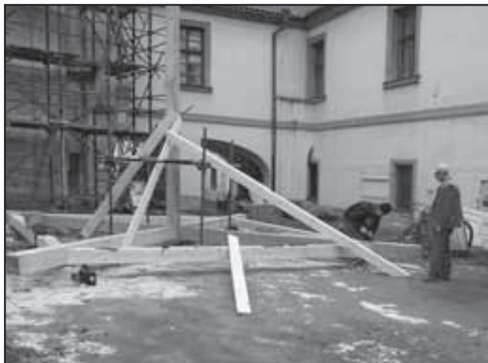
Oprava staré vodárenské věže - sestavování nových krovů
