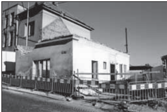
Bouráním tří domů započala dlouho očekávaná generální oprava vozovky v Podolecké ulici.
