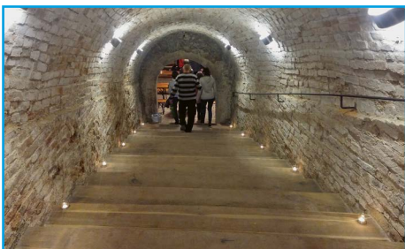
Schody ve sklepení pod „Konírnou“
