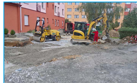
■ V průběhu měsíce září byla zahájena rekonstrukce zpevněných ploch u Městského centra komplexní péče
