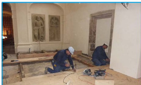
■ Dřevěná podlaha pod lavicemi byla opravena
