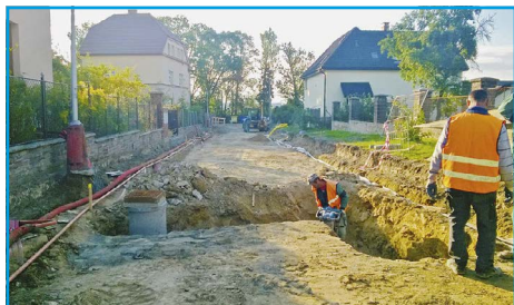
■ Probíhající rekonstrukce komunikace v ulici Krouského
