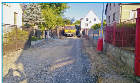
■ Rekonstrukce komunikace v ulici U Silvie
