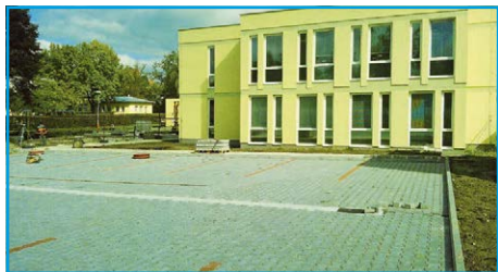
■ Výstavba parkoviště u Polikliniky byla dokončena
