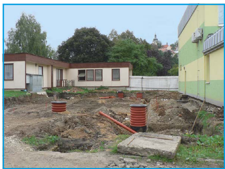
■ Přístavba polikliniky - byla vyhloubena základová jáma a položena dešťová i splašková kanalizace
