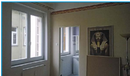
■ Výměna oken v čp. 39 na Husově náměstí byla rozdělena do tří etap
