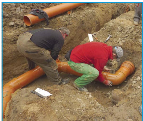
■ Přístavba polikliniky - pokládání dešťové a splaškové kanalizace
