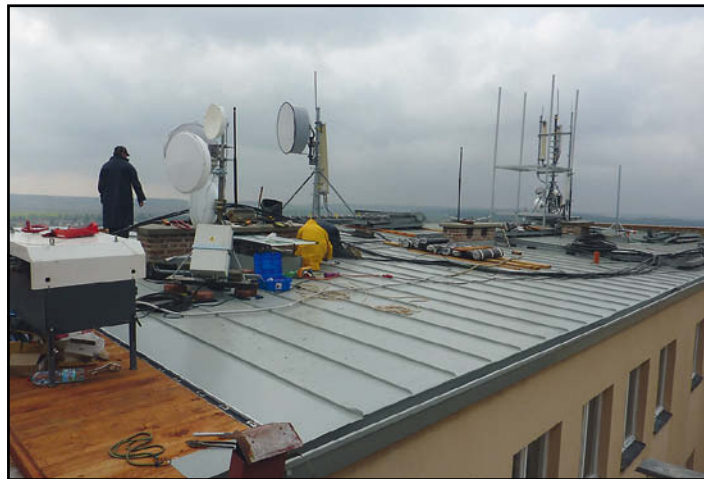
■ Po přemístění antén pro příjem mobilního signálu práce na opravě střechy Zálůžny (Husovo náměstí čp. 39) pokračují
