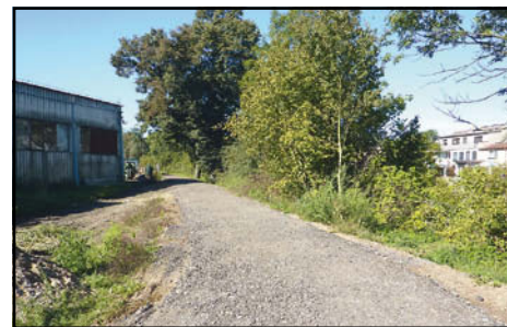
■ Stezka z ulice Cukrovarská až k bývalému železničnímu mostu byla dočasně zpevněna asfaltovým recyklátem
