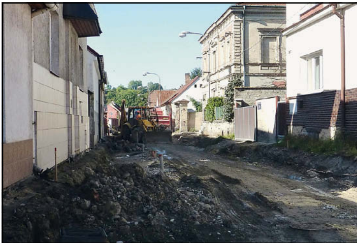
■ Rekonstrukce komunikace v ulici Soumarova – pokračující práce na opravě a čištění uličních vpustí
