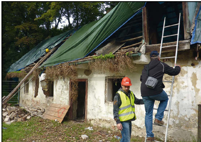
■ Rekonstrukce plochy u zámku a domu čp. 172 na Plajchu – v polovině měsíce září bylo předáno staveniště firmě SYNER s.r.o. Liberec a ihned byly zahájeny práce.
