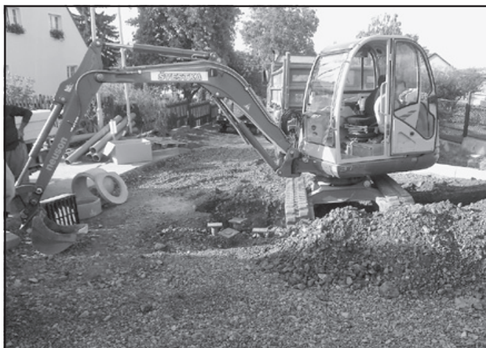
Dokončovací práce povrchu na křižovatce ulic Soukalova a U Vodojemu
