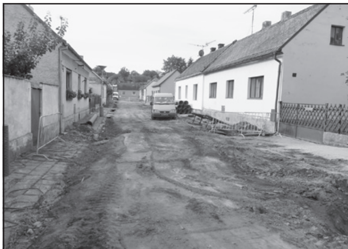
V ulici Wolkeho je dokončena hlavní trasa nové dešťové kanalizace
