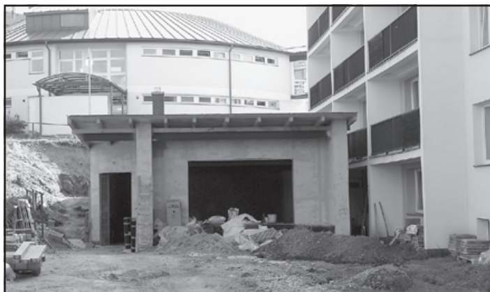
Přístavba společenského sálu k budově Městského centra komplexní péče pokračuje
