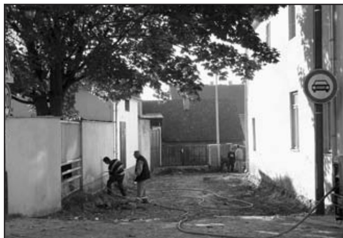
V uličce mezi školní budovou a ulicí Smetanova byla provedena oprava povrchu komunikace
