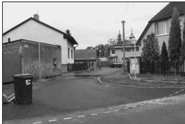
Rekonstrukce komunikace v ulici U Kostela – záběr od ulice Lidické ze dne 29. 9. 2010
