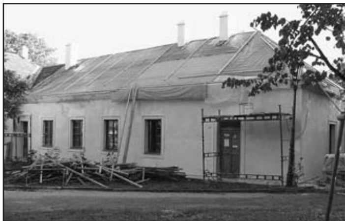
Na východním křídle čp. 50 v zámeckém areálu byl opraven krov
