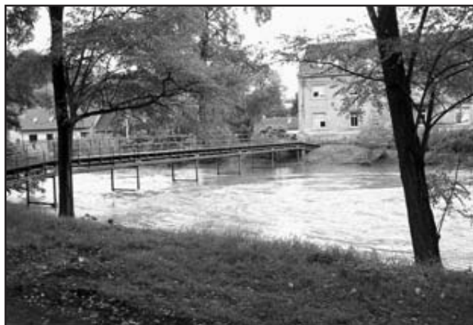
Lávka přes „Tůň“
