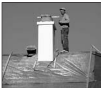
Komíny na čp. 50 v zámeckém areálu byly opatřeny novými hlavicemi ve stejném provedení jako na budově sousední družiny
