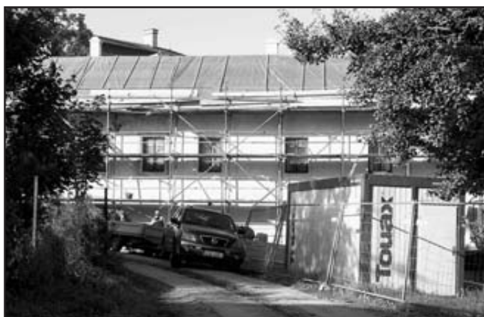
Oprava domu čp. 50 v zámeckém areálu – jsou hotové opravy vnějších omítek (pohled z „plajchu“)
