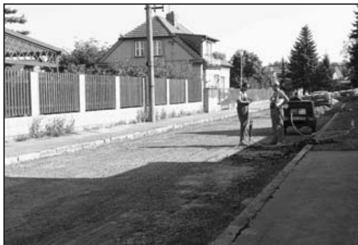
I ve Šnajdrově ulici probíhala oprava povrchu komunikace
