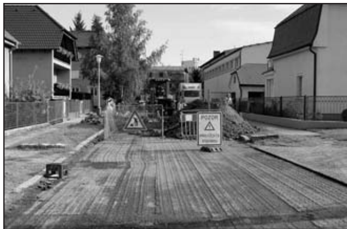
Oprava komunikace v ulici Jana z Dražic
