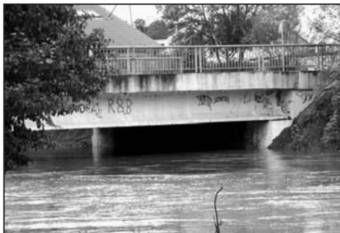
Jizera - přístupový most do společnosti Carborundum Electrite a.s.
