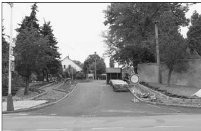
Rekonstrukce komunikace v ulici U Kostela – záběr od ulice Bratří Bendů ze dne 29. 9. 2010
