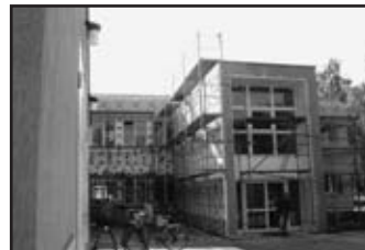
V průběhu měsíce pokračovaly práce na zateplení fasády v přední části budovy polikliniky
