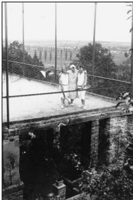
Na fotografii zhruba z roku 1928 je pohled na betonový kurt u Kischovy tiskárny. Dámy na ní jsou sestry Husovy a uprostřed p. Kischová
