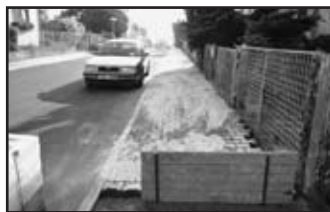
Na Štěpnici prošla část chodníku úplnou rekonstrukcí
