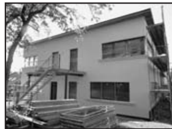
Práce na nové školce v Žižkově ulici probíhají uvnitř i zvenčí
