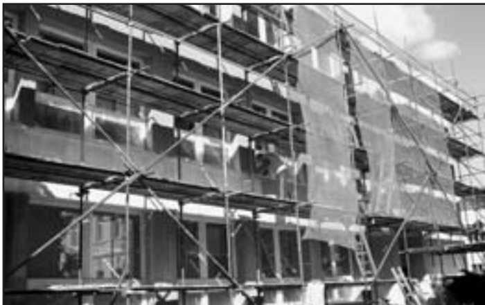
Začátkem měsíce září byly zahájeny práce na zateplení a následném natežení akrylátové omítkoviny na vstupní straně budovy ZŠ Pražská od ulice Pražská. Foto: MěÚ
