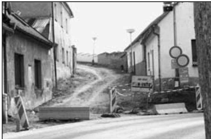
Rekonstrukce komunikace ve Smetanově ulici – byly provedeny výměny vadných vodovodních přípojek a napojení dešťových svodů na kanalizační přípojky jednotlivých objektů v části od křižovatky s ulicí M. Soumara po trafostanici. Foto: emje
