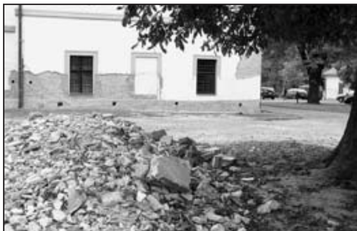
Probíhá oprava fasády na spodní části zámecké budovy Foto: MěÚ
