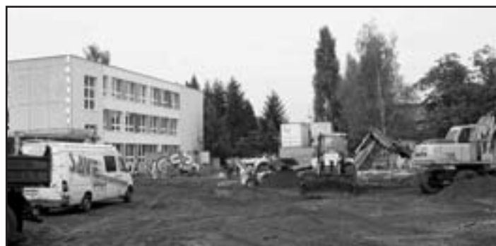
Přístavba tělocvičny k ZŠ Pražská pokračuje přeložkou sítí a stavbou plotu u sousední nemovitosti
