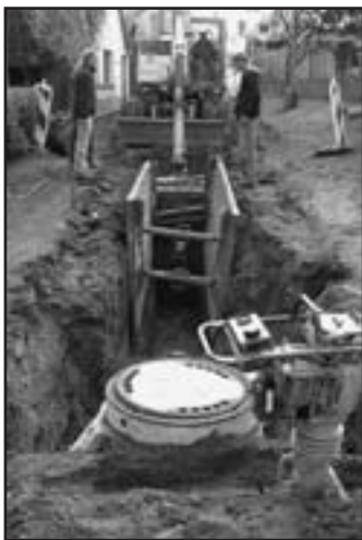
Dne 15. 9. 2008 bylo předáno staveniště kanalizace v ulici Dělnická. Ihned po předání vjela na staveniště technika. Foto: MěÚ
