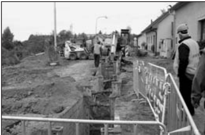
V měsíci září pokračovaly práce na dostavbě kanalizace – pokračovalo se v pokládce hlavního kanalizačního řádu v ulici J. V. Picka Foto: MěÚ
