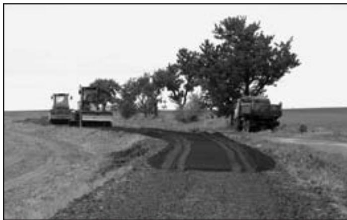
In-line stezka a cyklostezka – koncem září byla zahájena pokládka a hutnění podkladových vrstev ze šterku Foto: MěÚ
