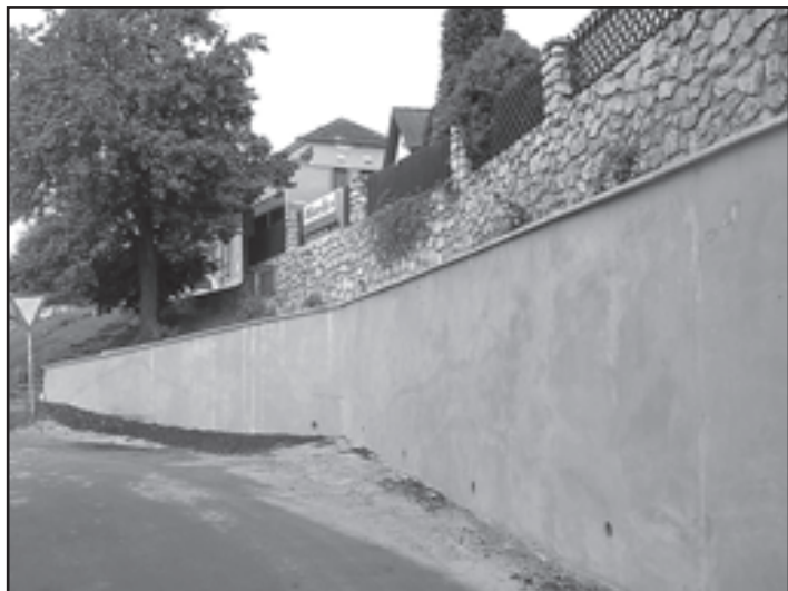
Rekonstrukce opěrné zdi v ulici Kordinův v Obodři je dokončena.
