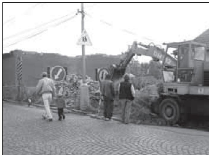
Rekonstrukce Podolecké ulice začala demolicí několika domků
