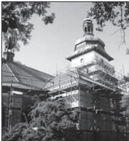
Opravené části zámeckého kostela a věže postupně vykukují z lešení.
