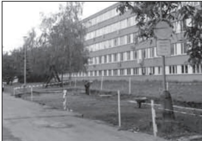
Budování parkoviště v Ořechové ulici
