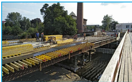
■ Na ocelové podpěrné konstrukci probíhá příprava bednění
