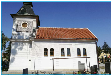
■ Zbývá dokončit vrchní nátěr fasády
