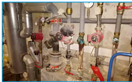
■ Měření a regulace budou vyměněny
