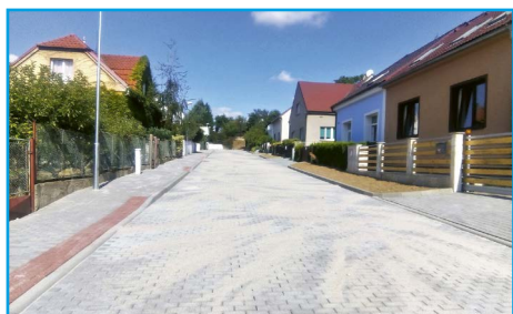
■ V ulici Kvapilova byla dokončena rekonstrukce
