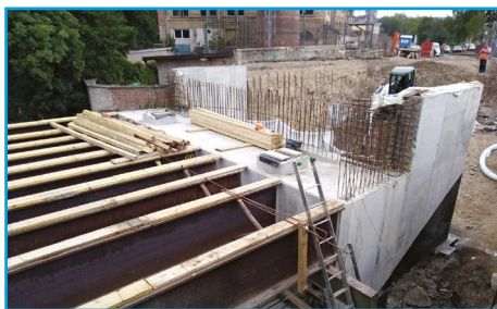
■ Probíhající betonáž mostního pilíře
