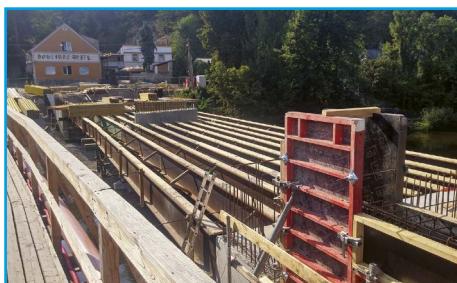
■ Příprava bednění pro betonáž mostovky
