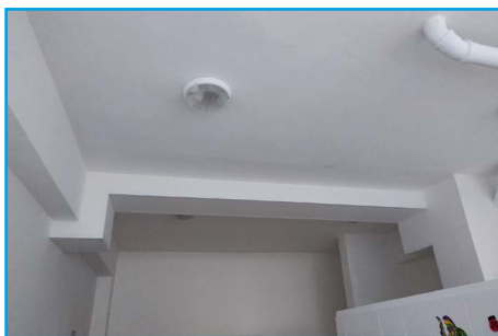
■ Práce byly dokončeny včetně oprav povrchů všech konstrukcí
