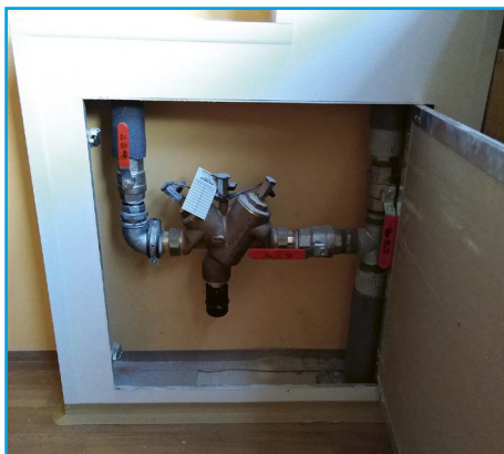
■ Rekonstrukce vnitřních rozvodů vody byla dokončena
