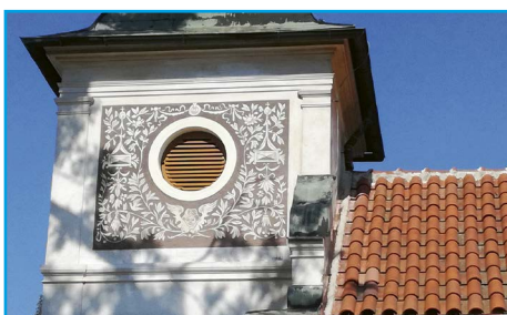
■ Do věžičky byly vsazeny kruhové dřevěné žaluzie
