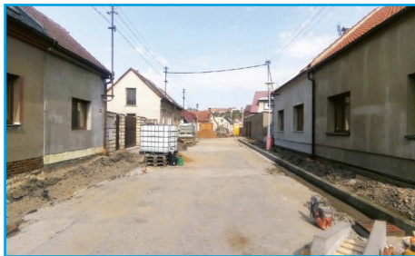
■ V ulici Kalistova pokračuje pokládka silničních obrubníků v druhé části ulice
