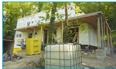
■ Nosné konstrukce druhého patra jsou vyzděny
