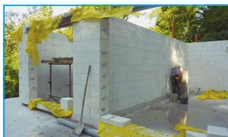
■ Stavba nosných konstrukcí druhého patra
