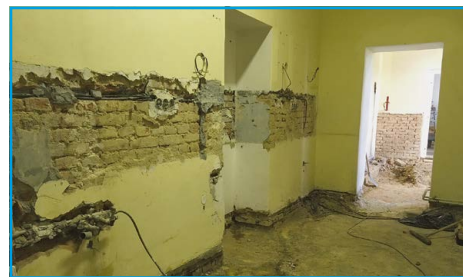
■ Rekonstrukce kuchyňky v ZŠ Husovo náměstí
