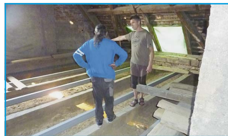
■ Mezi dřevěné stropní trámy byly osazeny ocelové nosníky pro zvýšení únosnosti stropu
