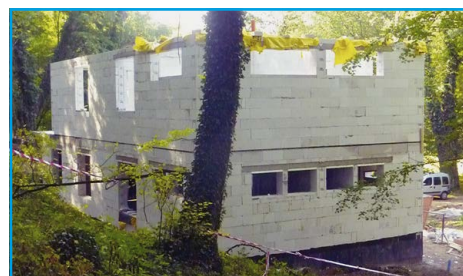
■ Stavba je připravena pro osazení střešních vazníků
