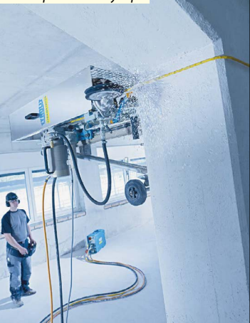
Ukázka použití Lanových pil (Example of cable saw use)
