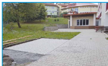
■ Stavba přístřešku na kola za budovou MěCKP – v průběhu měsíce srpna byla položena zámková dlažba (na snímku stav ke dni 24. 8. 2015)
