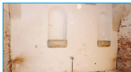
■ V konírně se zachovala původní kamenná koryta pro koně
