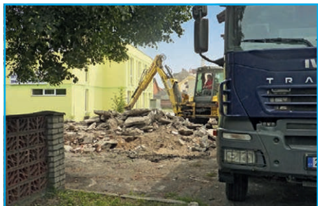
■ Původní dětské zdravotní středisko bylo postaveno v letech 1978-1979 na místě rodinného domu. Město pro tento účel tento dům vykoupilo, ale vzhledem k jeho špatnému stavu upustilo město od původního záměru rekonstrukce domu a rozhodlo o nové výstavbě. Investorem bylo město Benátky nad Jizerou a výstavba byla provedena svépomocí. Projektantem dětského zdravotního střediska pro dva obvody byl Ing. arch. Jiří Podolský. Pro zajištění rychlé výstavby se
