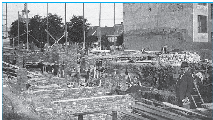
■ Stavba Okresního domu čp. 41, Husovo náměstí
