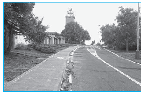
■ Opravený chodník v ulici Dražická
