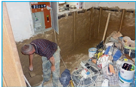
■ Kostel Narození Panny Marie – provádění omítek poškozených vlhkostí ve zdivu
