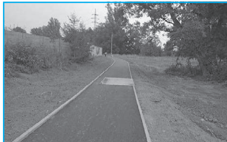
■ Pokládka poslední části asfaltového povrchu
