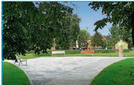
■ Výstavba City parku se blíží ke konci, probíhají závěrečné terénní úpravy, dosívání a dosadby
