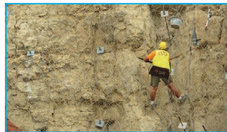
■ Po celé délce skály byly ke kotvám připevněny ochranné sítě
