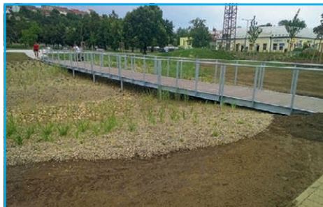
■ Byly usazeny lávky přes odtokový průřeh pro, který byl ponechán pro případný odtok povodňové vlny
