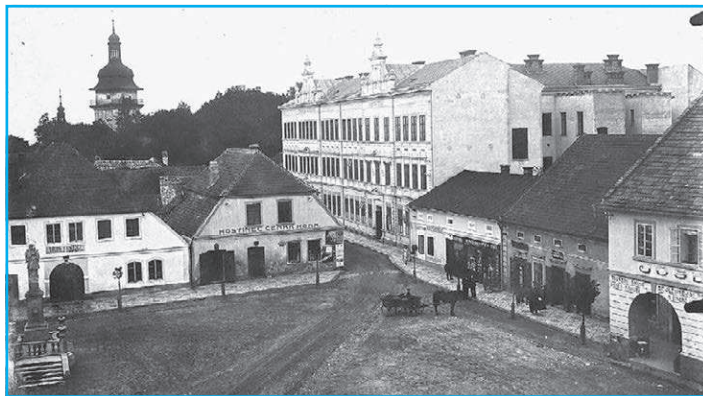
■ Pohled na dva hostince na Husově náměstí, na jejichž místě byl v letech 1925 – 1927 postaven Okresní dům
