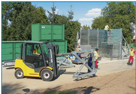
■ Ulice Dělnická - demontáž a zpětné rovnání do šesti plechových kontejnerů bylo daleko pracnější než vlastní výstavba
