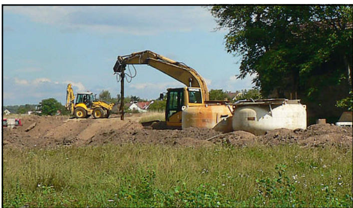
■ Protipovodňová opatření - výstavba sypané hráze (stav v sobotu 25. 08. 2012 odpoledne)
