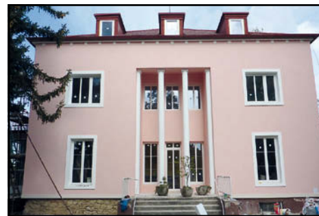
■ V MŠ Růženka bylo provedeno zateplení a zároveň natažení nové fasády na východní a jižní straně budovy
