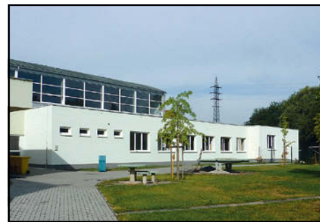
■ Rekonstrukce objektu Školní jídelny v ul. 5. května byla dokončena
