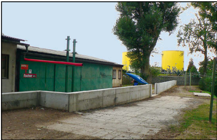
■ Protipovodňová opatření – u vodního slalomu jsou práce téměř dokončeny
