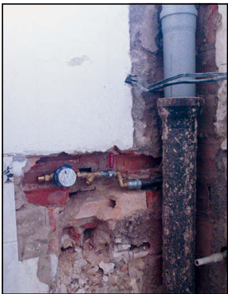
■ V č.p. 39 na Husově náměstí pokračuje rekonstrukce stoupaček a montáže vodoměrů
