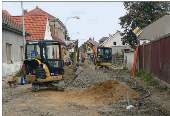
■ Rekonstrukce komunikace v ulici Miroslava Soumara - postupně jsou rozebírány chodníky, obruby a komunikace ze žulových kostek
