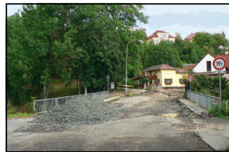
■ Rekonstrukce komunikace v ulici Miroslava Soumara – byly zahájeny práce na opravě mostku
