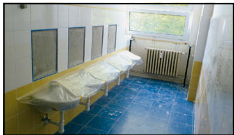
■ V MŠ Poupátko byla dokončena rekonstrukce čtyř sociálních zařízení
