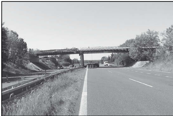
■ V současné době je dokončena vlastní nosná konstrukce a připravena pro betonáž říms. Provádí se úpravy terénu pod mostní konstrukcí, odláždění svahů a odvodnění
