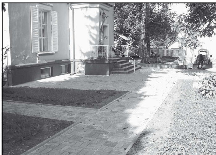
Rekonstrukci chodníků a zpevněných ploch v MŠ Růženka prováděla firma TOMAN, opravy komunikací
