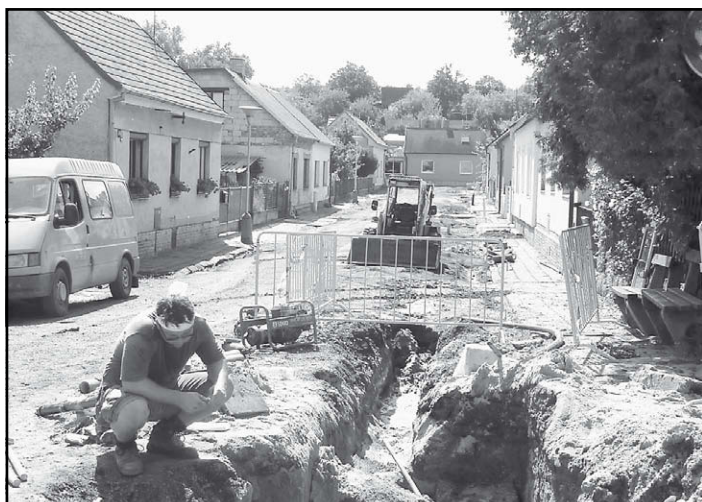
V posledním týdnu měsíce pak zahájila firma Gastrend v ulici Jiřího Wolkera práce na vybudování nové dešťové kanalizace
