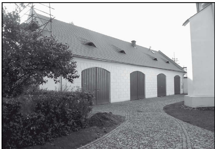
Rekonstrukce „kočárovny“ v areálu zámeckého parku bude v září pokračovat pracemi uvnitř objektu
