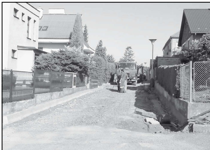
Druhá etapa rekonstrukce komunikace v ulici Soukalova
