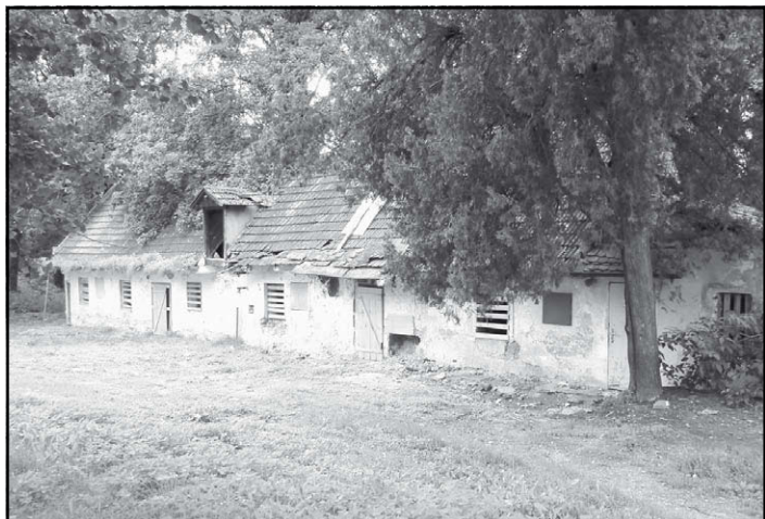
Původní stav budov na Plajchu (foto dole) a stav současný (foto nahoře)
