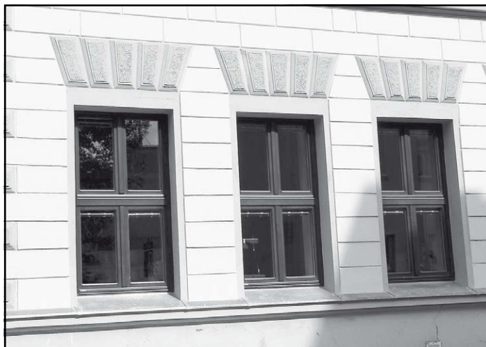
Na škole byla vyměněna okna a opravena fasáda
