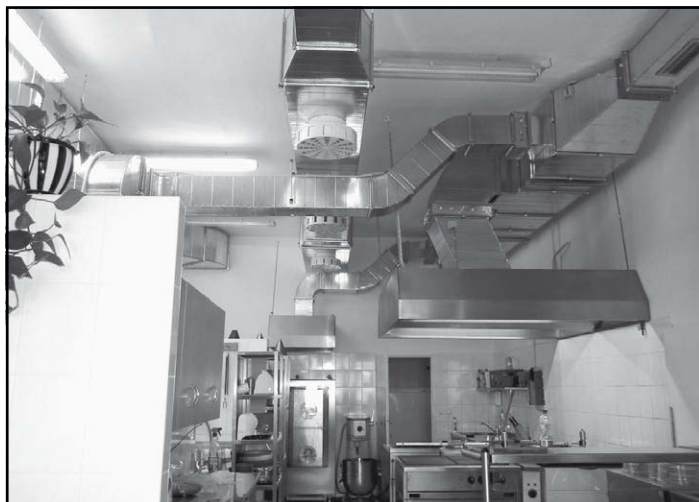
Rekonstrukce vzduchotechniky ve Školní jídelně na Husově náměstí
