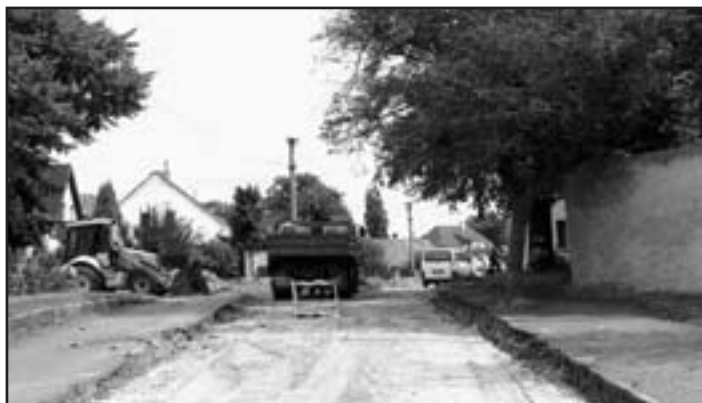
Firma COLAS CZ a.s. v ulici U Kostela provedla skryvku povrchu komunikace i chodníků
