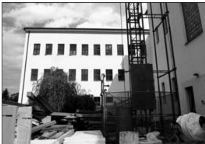
V ZŠ Husovo náměstí byla v zadní části školní budovy dokončena výměna oken za nová dřevěná
