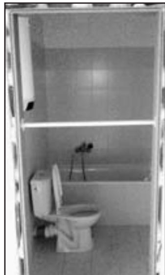
Rekonstrukce bývalé ubytovny města na náměstí 17. listopadu
