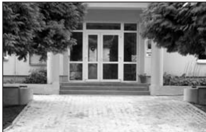
V průběhu měsíce srpna byl opraven přístupový chodník k MŠ Jizerka a Pavilon
