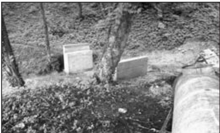
Při obnově můstků v zámeckém parku pokračují práce na základových konstrukcích pro všechny tři můstky Foto: MěÚ
