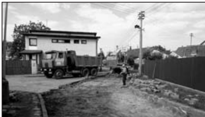
V současné době probíhá v ulici U Kostela výměna vodovodních popř. kanalizačních přípojek k jednotlivým nemovitostem podle požadavků jejich majitelů
