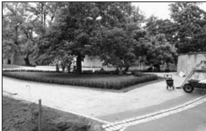
Při rekonstrukci zámeckého parku je prakticky již dokončena cestní mlatová síť, kde chybí realizovat pouze vstupní úsek
