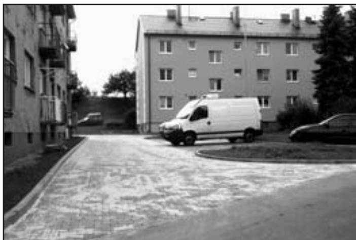
Pokládka zámkové dlažby na chodníku podél domu čp. 498 a 499 a terénní úpravy byly dokončeny
