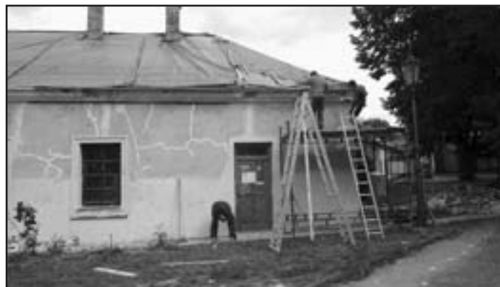
Čp. 50 v zámeckém areálu – ke konci měsíce srpna se začalo také s opravou střechy Foto: MěÚ a emje
