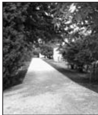
Asfaltový povrch chodníku byl odstraněn a postupně bylo provedeno zadláždění betonovou zámkovou dlažbou
