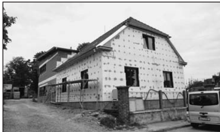
V čp. 432 Žižkova ul. probíhá při výstavbě nové školky zateplování fasády
