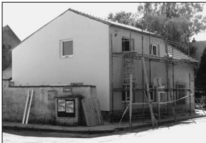
Úprava domu čp. 96 Pražská ul. – dokončování fasády
