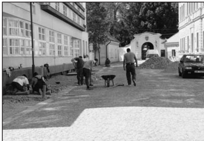
Dokončování dlažby na chodníku podél čp. 41 - komunikace a chodníky v této části před školou byly koncem srpna dokončeny
