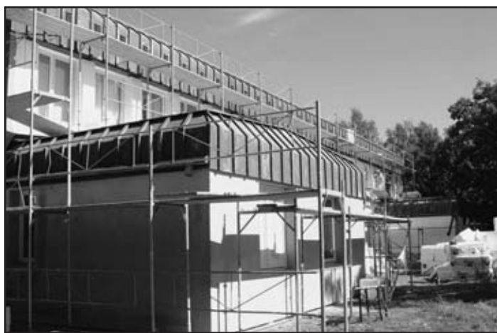
V srpnu proběhla výměna všech oken, vyzděny meziokenní sloupky a byly zahájeny práce na zateplení fasády budovy polikliniky
