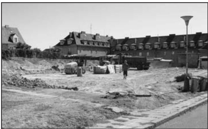
Zemní práce na výstavbě víceúčelového hřiště v lokalitě U Silvie byly zahájeny v druhém srpnovém týdnu
