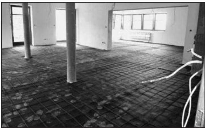
Čp. 432 Žižkova ulice – Příprava pro betonování podlahy v objektu nové mateřské školy
