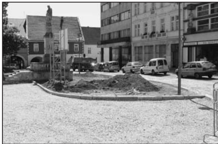
Plocha uprostřed Husova náměstí je připravena na pokládku dlažby
