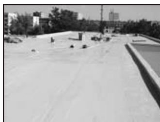
Položení nové střešní krytiny na budově MŠ Poupátko
