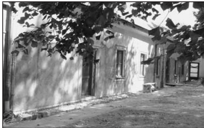
Do výše horní hrany oken byla provedena sanační omítka na budově školní družiny ZŠ Husovo náměstí
