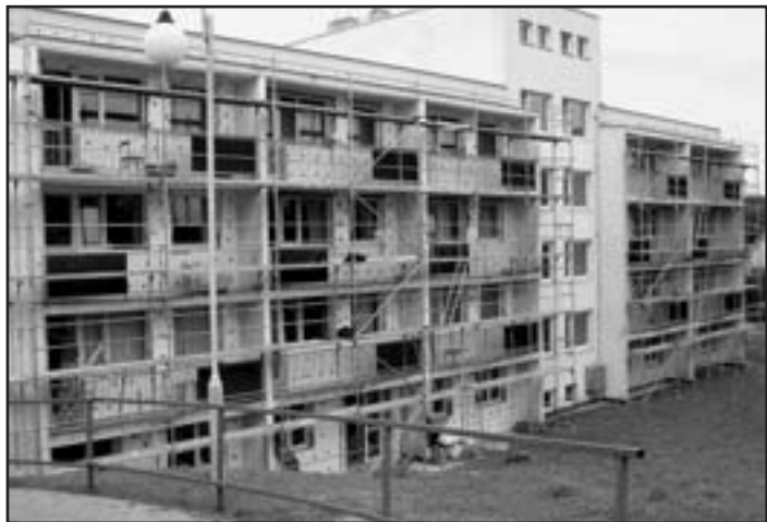
V polovině měsíce byly zahájeny práce na zateplení zadní strany budovy MěCKP Foto: MěÚ
