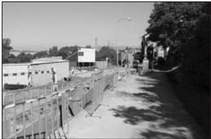
Pokládání hlavního kanalizačního řadu v ulici J. V. Picka Foto: MěÚ
