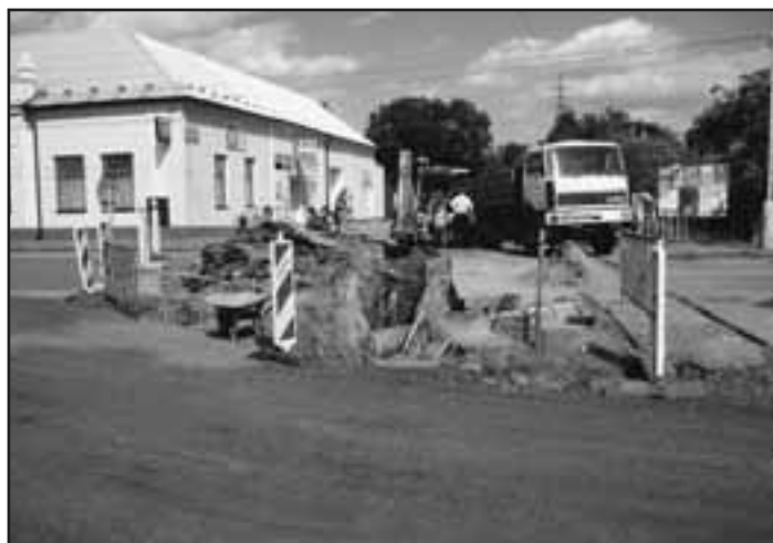
Práce na výstavbě komunikace k areálu Karba byly zahájeny
