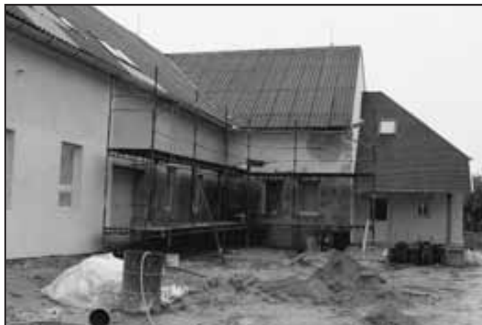
Stavební skupina Technických služeb města dokončuje další část fasády na budově Technických služeb města Foto: Ing. Alena Kratochvílová
