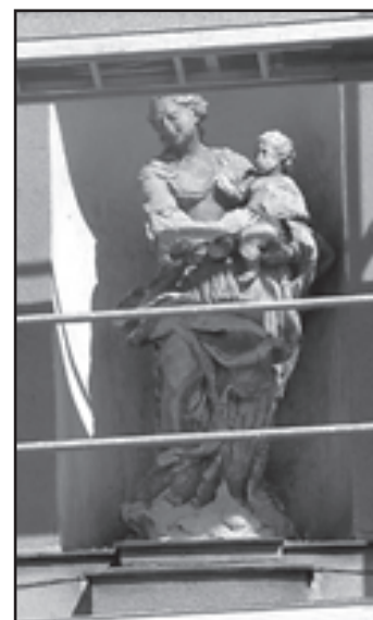
Současně s opravou fasády domu čp. 76 na Husově náměstí se bude opravovat i socha Panny Marie umístěná ve výklenku tohoto domu.
