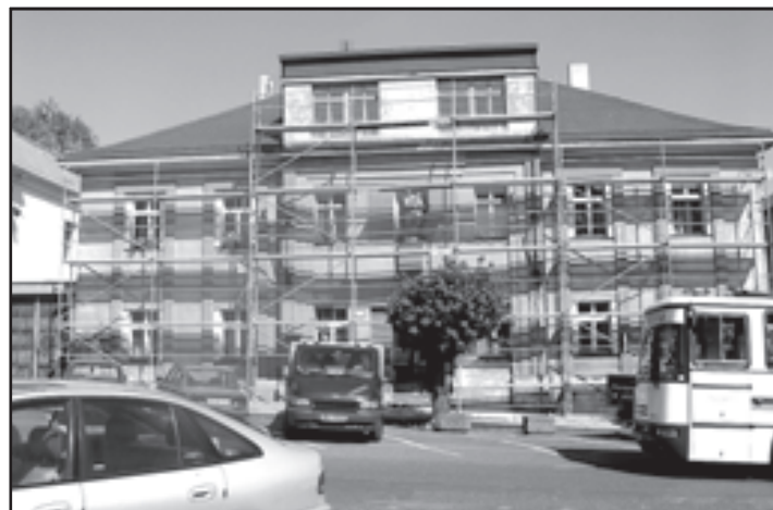
Oprava fasády a oken domu čp. 76 na Husově náměstí začala.
