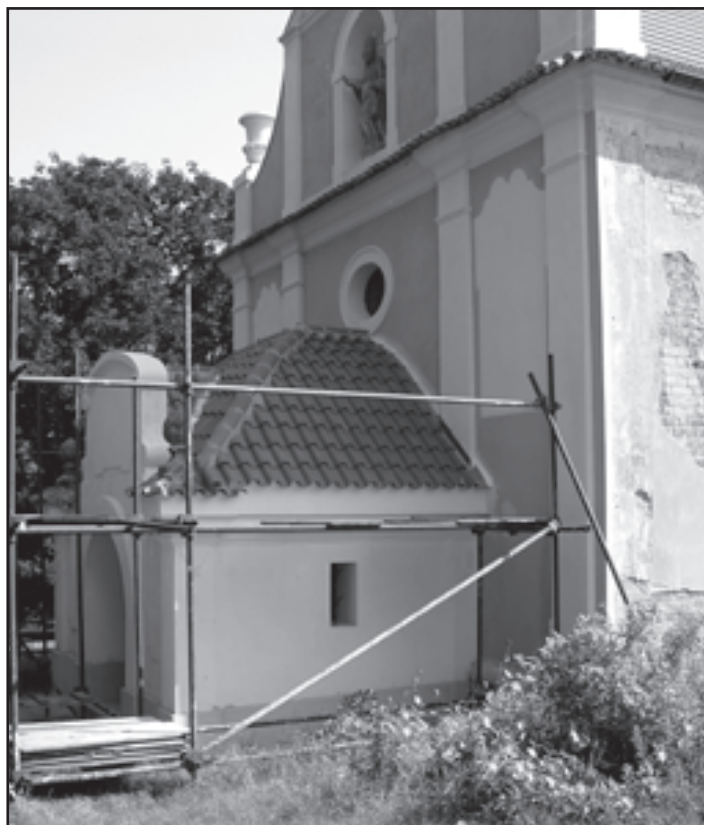
Nová střecha na vstupních prostorách kostela sv. Martina v Dražicích
