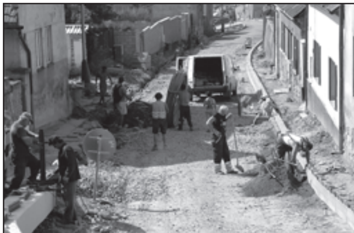
Rekonstrukce komunikace v Podolecké ulici
