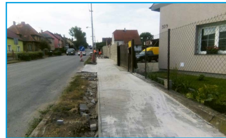
■ Rekonstrukce chodníku v ulici Bratří Bendů
