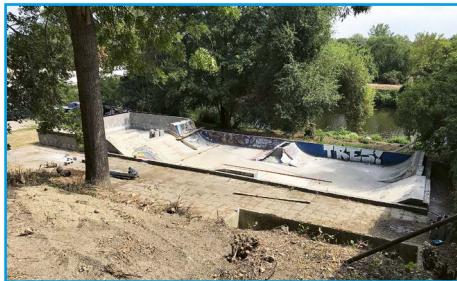
■ V měsíci červenec přestavba skateparku pokračovala
