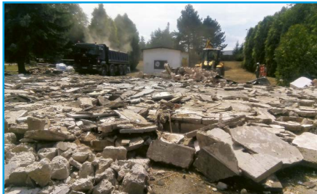
■ Probíhá druhá etapa demolice skautské klubovny
