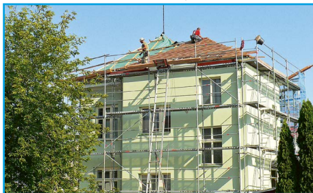
■ Oprava střechy městské knihovny
