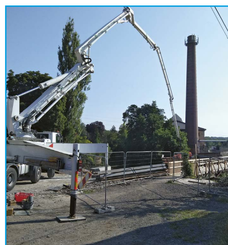
■ Betonářské práce na středovém pilíři nového mostu
