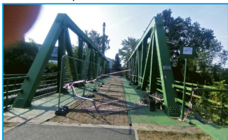
■ Výměna dřevěného povrchu na bývalém železničním mostě
