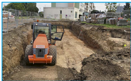
■ Jáma připravená pro umístění vsakovacích tunelů na dešťovou vodu
